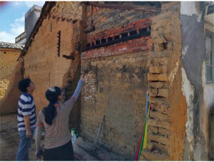
鹤山市宅梧镇纪委对危房居住情况进行监督检查
